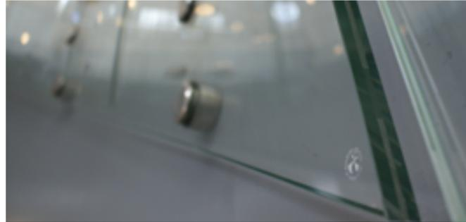
Desde el punto de vista de la ingeniería, el vidrio laminado con SentryGlas® Plus supone todo un cambio en comparación con el PVB; es dos veces más resistente a las tensiones mecánicas que el vidrio laminado tradicional y puede ser cuatro veces más rígido en función de la carga y las condiciones de apoyo. Ello resulta en un mejor rendimiento general del laminado, una característica de ingeniería muy deseable.
